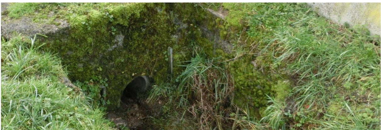
Figure 13: Buse en aval du fossé longeant le chemin rural dit "de Montaigu"
